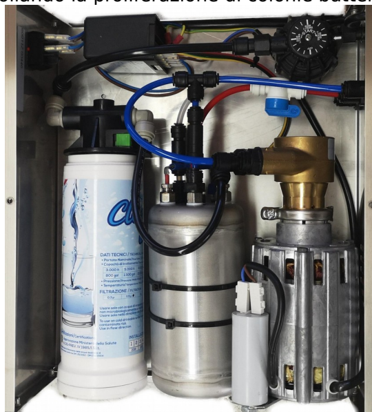
Particolari interni - Vista alto
